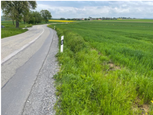
Abb. 6: Nördliches Plangebiet mit benachbarter Baumreihe auf Grünstreifen entlang der L1046.
